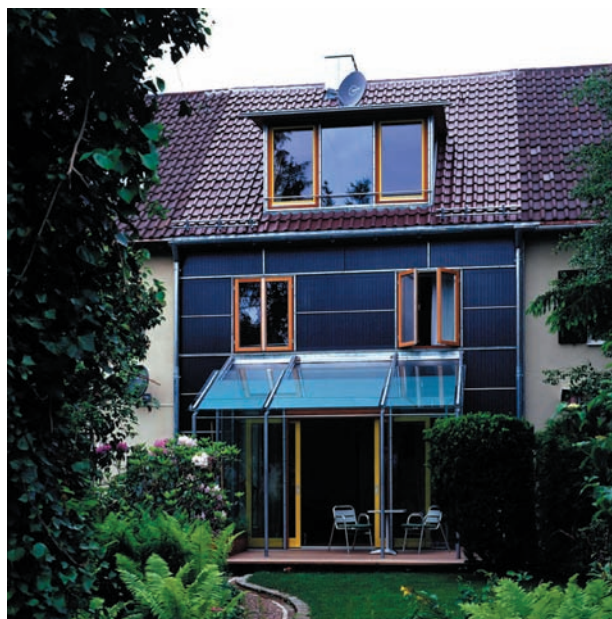
Abb. 2, 3: Ansicht Süd alt/neu, Reihenhaus in München, erbaut 1956, erneuert 2001 Reduktion Heizbedarf um Faktor 10 (Demoprojekt Vakuumdämmung, Solarnutzung, Lichtblau Architekten - München)
