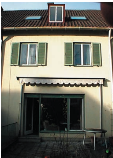
Abb. 2, 3: Ansicht Süd alt/neu, Reihenhaus in München, erbaut 1956, erneuert 2001 Reduktion Heizbedarf um Faktor 10 (Demoprojekt Vakuumdämmung, Solarnutzung, Lichtblau Architekten - München)
