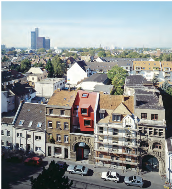
↑ Haus Wellendorf in München (Kahlfeldt Architekten)
