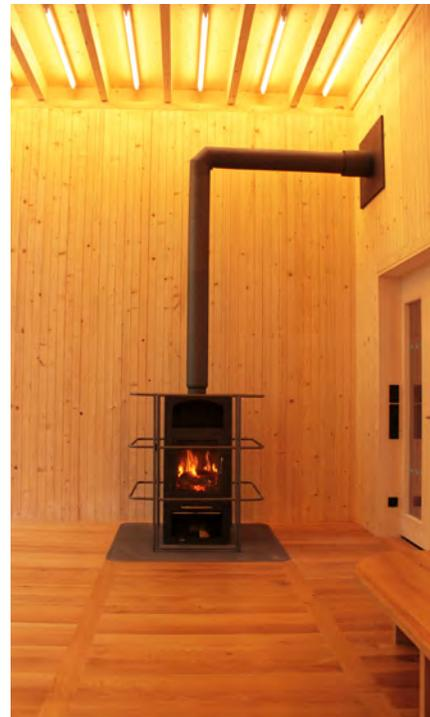
Das Gebäude erhält außer dem Saal eine Teeküche und einen Abstellspeicher, in dem temporär aufgestellte Möbel für eventuelle Schulungen zwischengelagert werden können. Da der Bau nur temporär genutzt wird, ist er nicht an die Zentralheizung angeschlossen. Im Zentrum des Saals wird ein großer Holzofen installiert, an dem das Heizen mit Holz demonstriert werden kann. Der Holzofen ist so ausgelegt, dass das ganze Bauvolumen auf Zimmertemperatur aufgeheizt werden kann.
